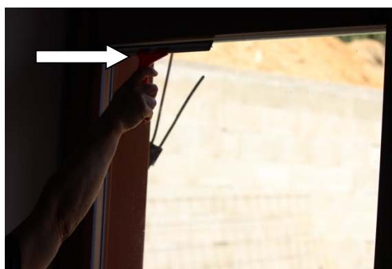
9. Přiložení stěrky na okno.
